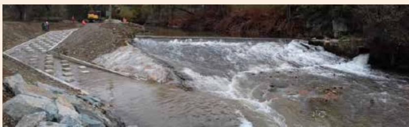
Vue d'ensemble du seuil et de l'ouvrage de contournement (© SMBVA)
