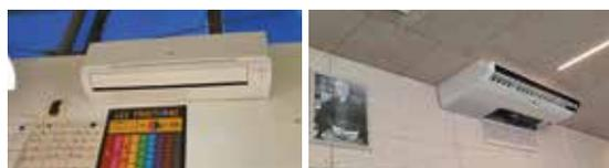
A l'école élémentaire, dans le Dojo et la salle Lachenal, du matériel de climatisation performant, moderne, et économe en énergie a été installé (coefficient de performance de 3.53 (Classe A+).
